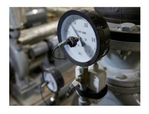
メータの指針の動きを磁気で計測。定点観測作業をなくし、遠隔での監視・管理を実現します。カメラ方式と比較して省エネ・省スペースかつ耐環境に優れ、既存の設備へ簡単に後付け可能。作業員の業務負荷を削減するだけでなく読み取りや転記のミスも減らせるため、正確に記録しながら業務の効率化が図れます。
